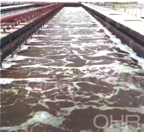
↑某焦化废水新建项目。处理水量3600m 3 /D。配合纤维填料使用，池顶加盖。
