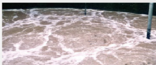
乳业厂 16年免维护，曝气槽从4个减至2个
