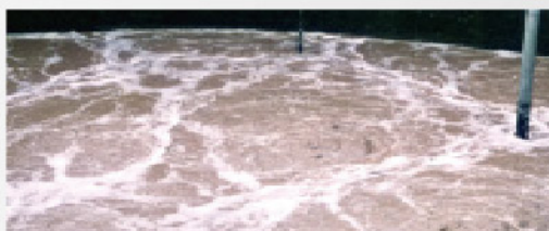
乳业厂 16年免维护，曝气槽从4个减至2个
